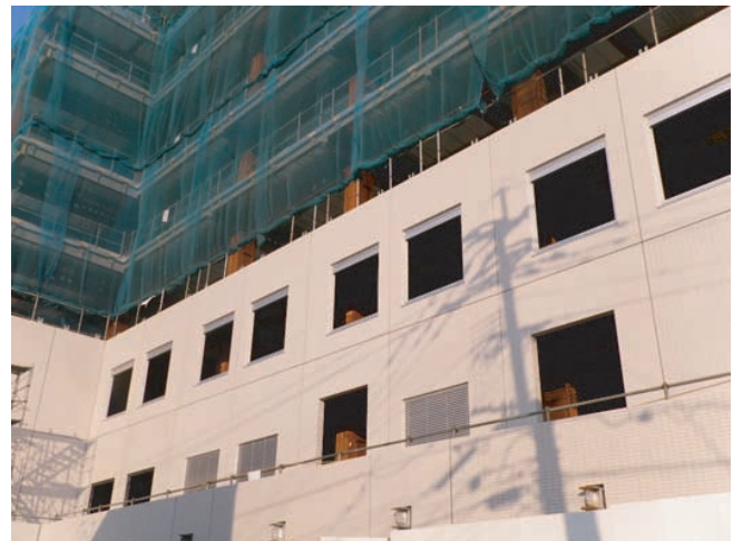
1月下旬、3階外壁PCパネル取付状況
