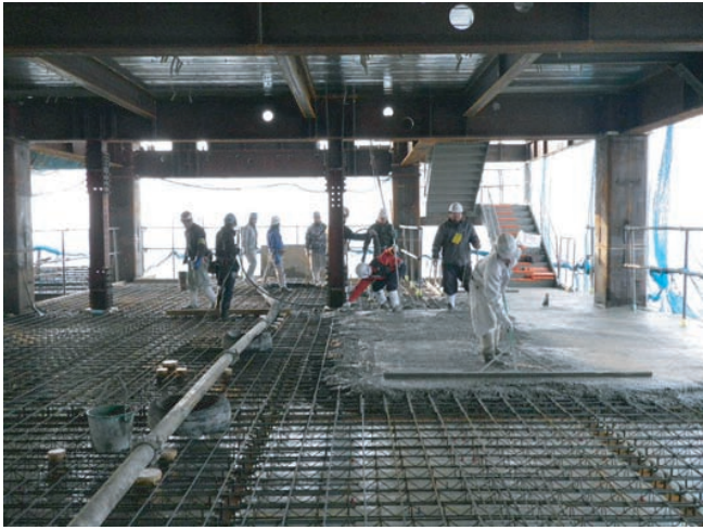
1月上旬、12階床コンクリート打設状況
