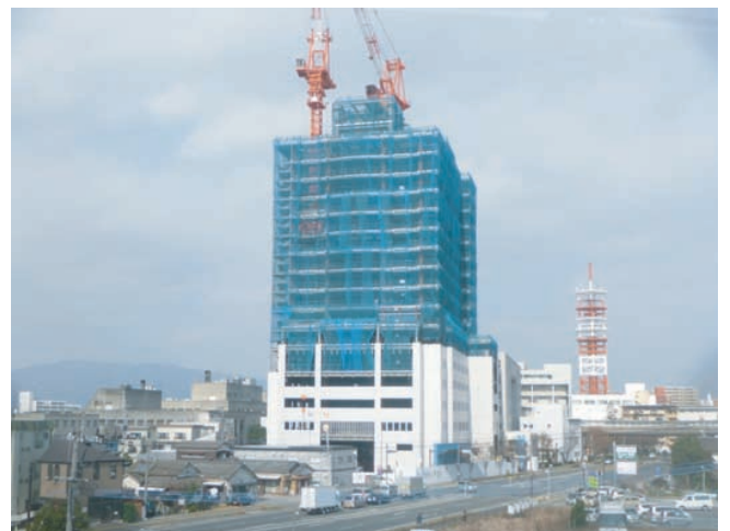
1月下旬、外壁施工状況 南からの全景
