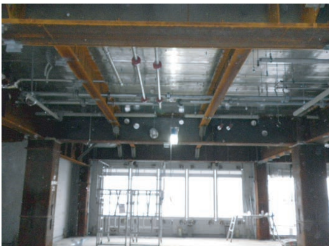
1月下旬、3階内部設備配管施工状況
