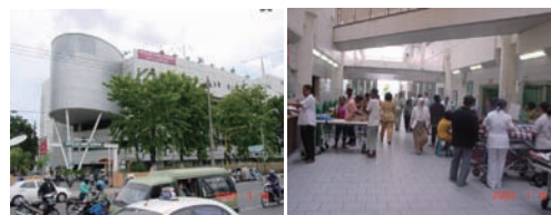
IRD (救急棟) の外観
